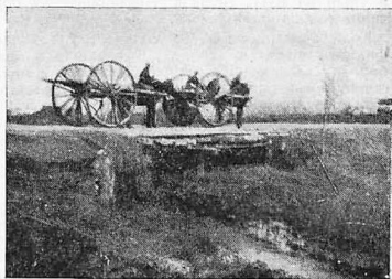
Мост по дороге Коканд — Шорсу
