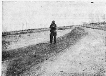
Вид опытного участка через несколько месяцев после постройки
